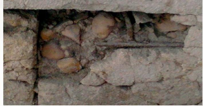
تساقط الطبقات السطحية للحجر الصناعي بسور الجامعة وظهور حديد التسليح وطبقة الخرسانة
